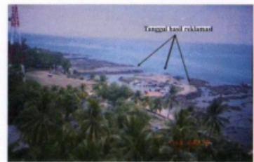
Gambar 7. Kondisi pantai pada penelitian tahun 2004 yang telah direklamasi. Lokasi bagian selatan fondasi mercusuar lama, gambar dilihat dari atas mercusuar baru di daerah Cikoneng pada waktu air surut.
