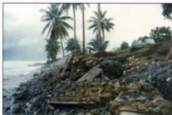
Gambar 3. Kondisi badan jalan yang mengalami torehan gelombang. Lokasi di pesisir bagian selatan Cikoneng (Sukardjono dkk., 1989).
