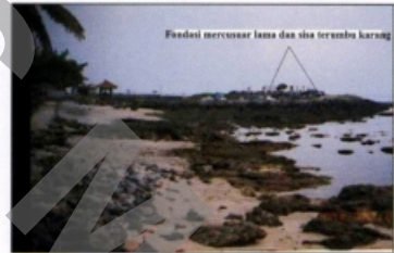
Gambar 6. Kondisi fondasi mercusuar lama pada saat penelitian tahun 2004 dan sisa terumbu karang yang mengalami abrasi di lokasi sama dengan Gambar 5.
