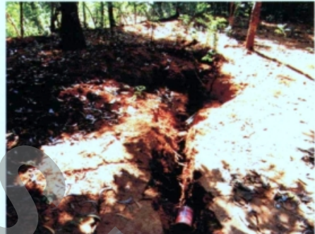
Foto 5. Rekahan tanah di daerah tinggi dengan arah N40°E lebar 30 cm. Lokasi Dusun Patuk, Kecamatan Patuk (ST 13). Di lokasi ini terdapat tiga jalur rekahan berarah hampir sama.
