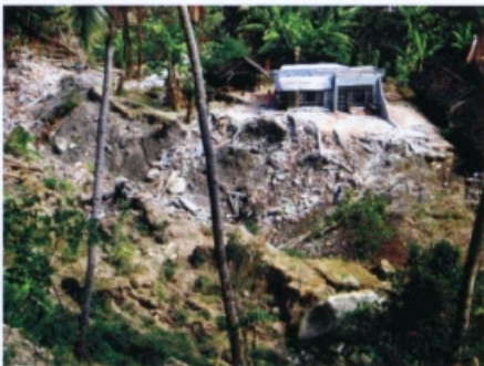
Foto 9. Longsoran lereng debris tua yang merusak empat rumah penduduk yang dibangun di atas lereng debris yang labil. Lokasi Dusun Sengir, Prambanan (ST 10).
