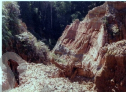
Foto 5. Erosi Jurang. Lokasi: Desa Kairagi.
