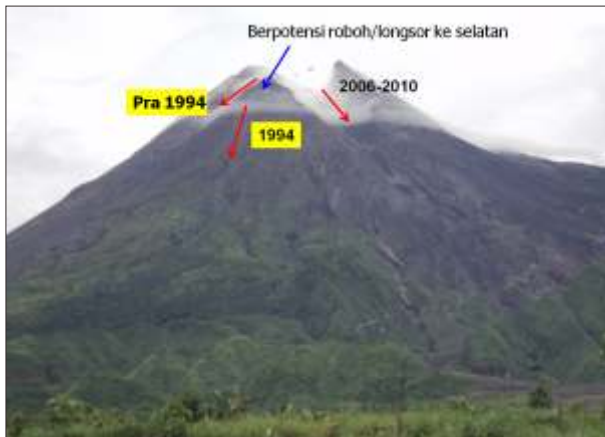
Gambar 17 Blok selatan tubuh G. Merapi, yang berpotensi roboh dan longsor ke selatan, antara arah kegiatan pra 1994 (ke barat – baratdaya) dan kegiatan 2006 serta 2010 (ke selatan – tenggara).
