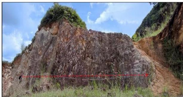
Gambar 6. Bentangan scanline pada lereng 2
